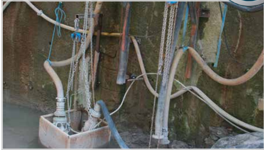
SPT-R-Schmutzwassertauchpumpen verfügen über ein Rührwerk für die Förderung problematischer Sand-Wasser-Gemische
