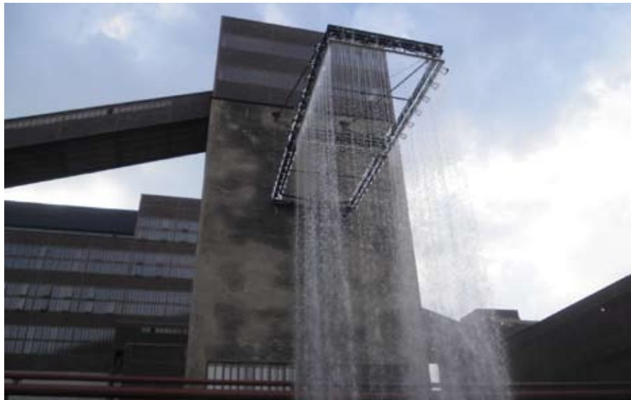
➔ Ca. 600 Düsen verteilen das Wasser und bilden damit die „Turm-Wände“.
