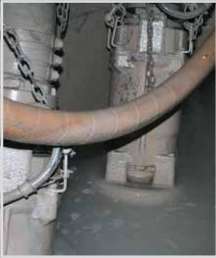
Selbst für ein ungeübtes Auge ist das sand- und kieshaltige, mit Betonit und Bohremulsionen versetzte Bergwasser zu erkennen. Eine Herausforderung für jede Abwasserpumpe
