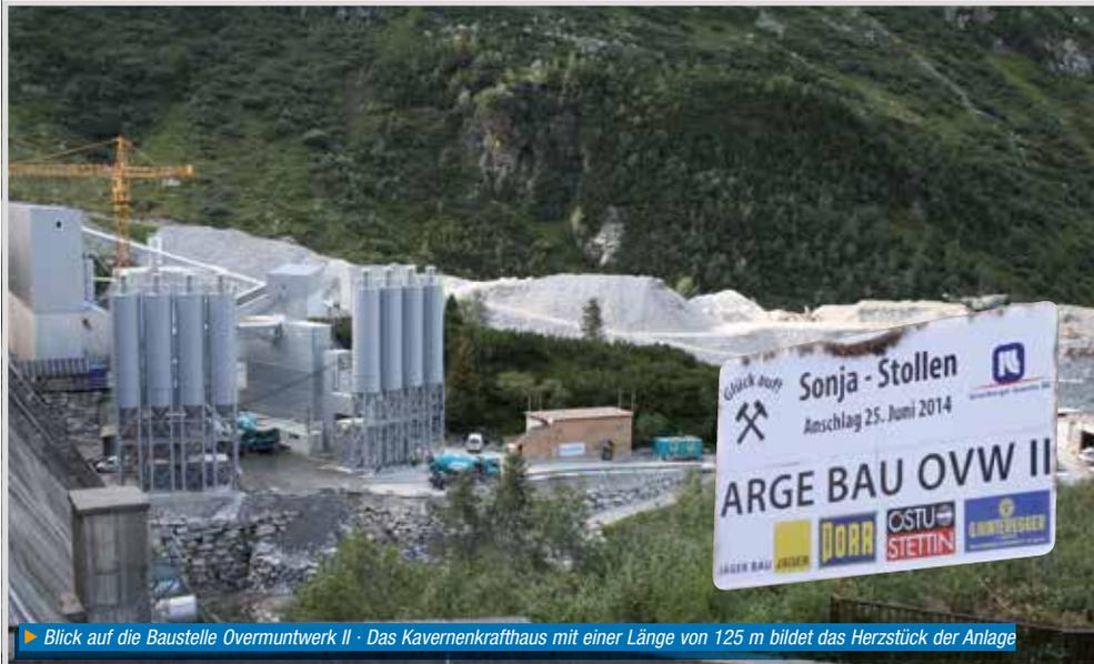
► Blick auf die Baustelle Obervermuntwerk II · Das Kavernenkrafthaus mit einer Länge von 125 m bildet das Herzstück der Anlage
